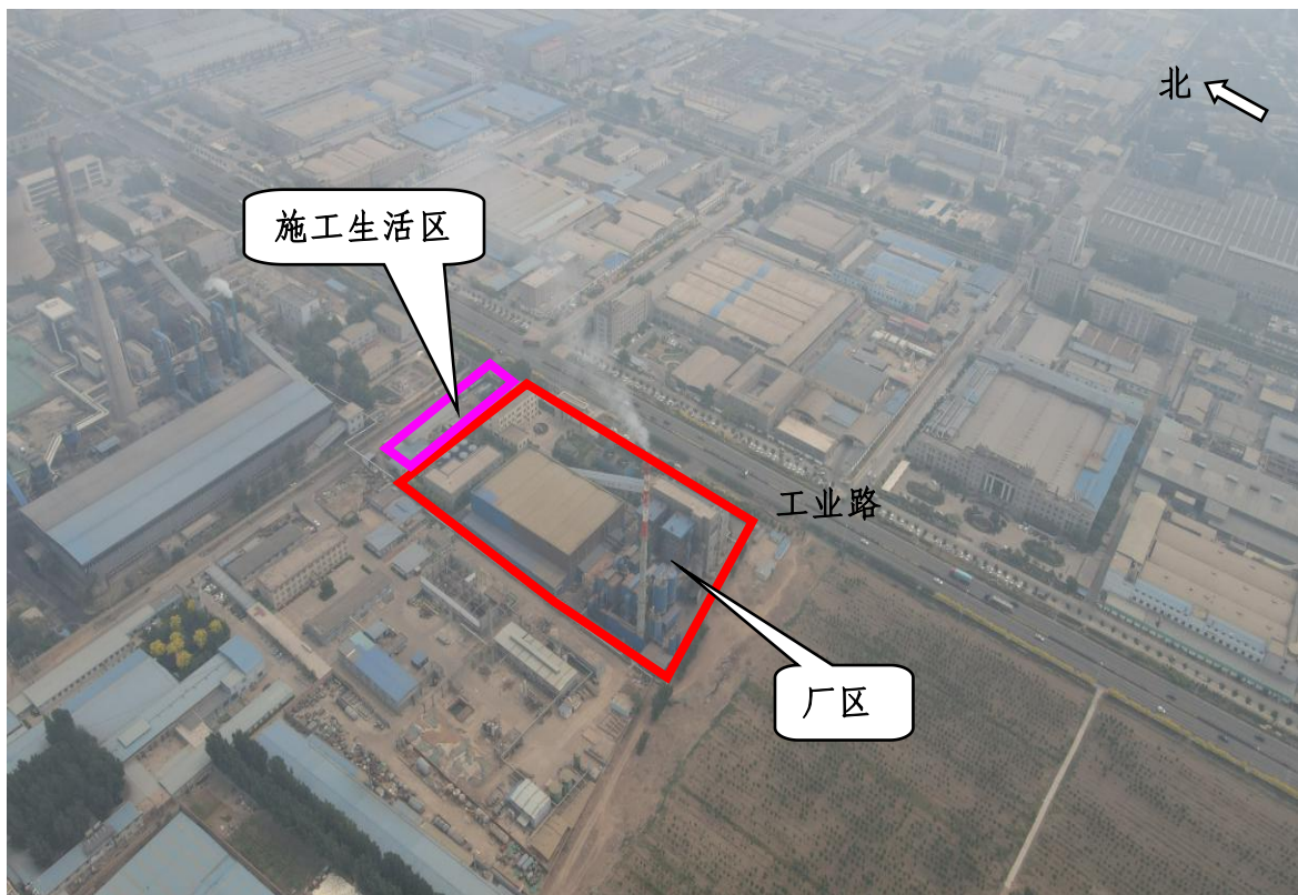
项目区航拍照片（拍摄时间 2021 年 5 月）
