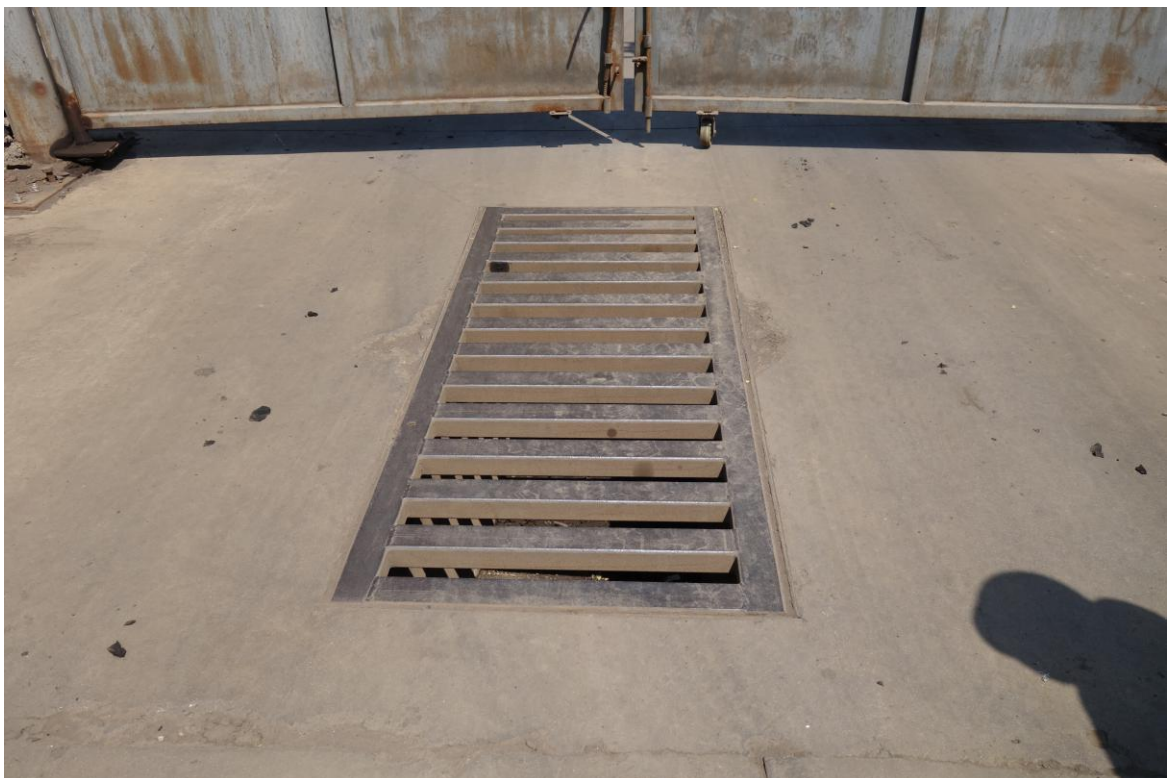
车辆冲洗池（拍摄时间 2021 年 6 月）
