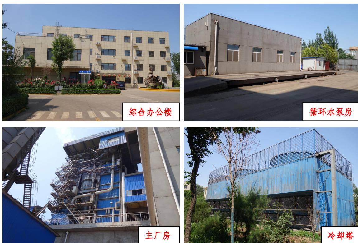
图 1-2 项目区构建筑物现状照片
