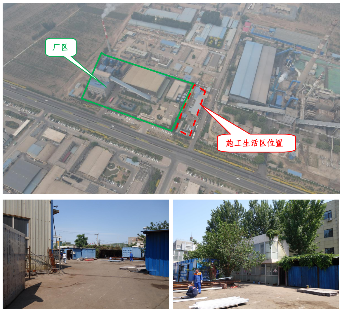
图 1-6 施工生活区位置及现状照片
