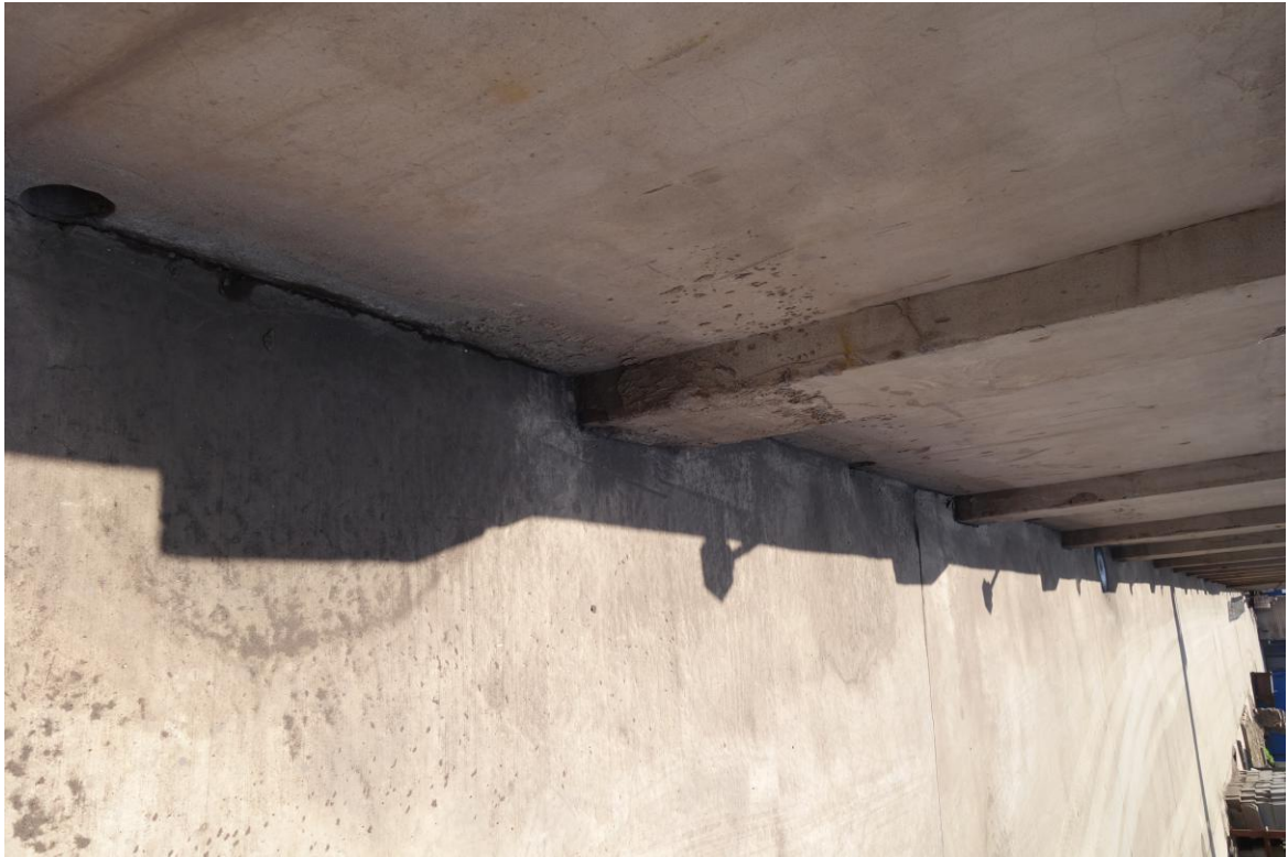
厂区内排水孔（拍摄时间 2021 年 6 月）
