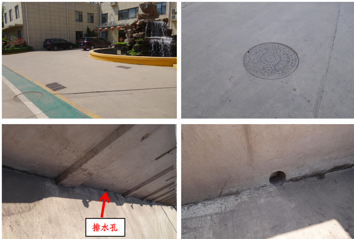
图 1-5 项目区各类管网现状照片
